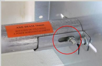
Pour les axes en **diamètre 76**, positionnez le boulon à l'horizontale.
